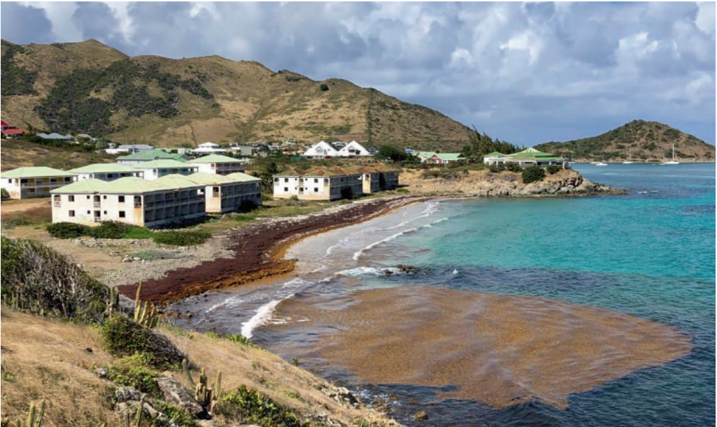
Résidences hôtelières endommagées et abandonnées après Irma et sargasses- ©Thierry BELTRAND
