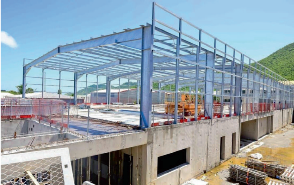
Travaux de construction du collège 900 ©Collectivité de Saint-Martin
